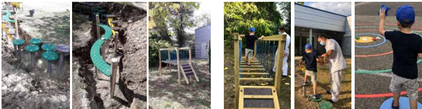
Quelques images des travaux
